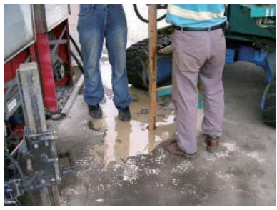
泵島旁測漏管施工
