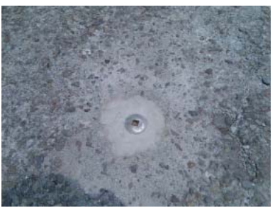
儲槽至泵島間管線區測漏管完工
