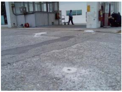
加設加油站管線及泵島測漏管
