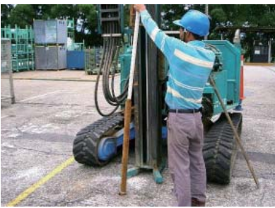
儲槽至泵島間管線區測漏管施工
