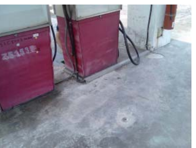
泵島旁測漏管完工
